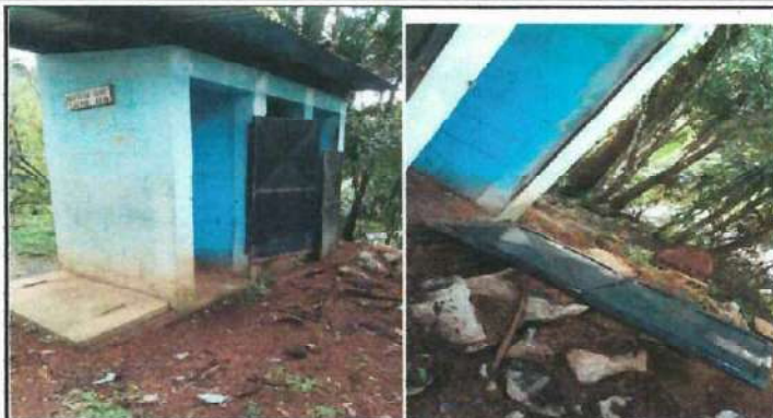
Foto 2: mantenimiento puertas de baños que son utilizados por los estudiantes, y repello en paredes
